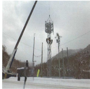
<建設中の基地局>
