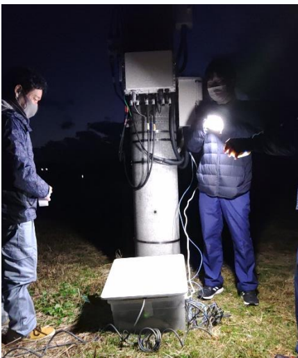
既存基地局の 光ケーブル代替
