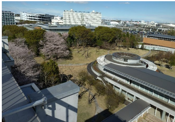
自治大学校寮最上階から見る中庭
