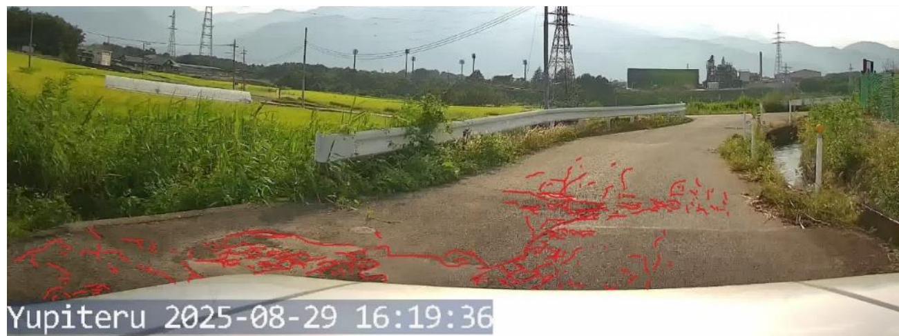
ドラレコデータを用いたAIによる舗装のひび割れ解析
