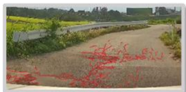
AIによるひび割れ検知
