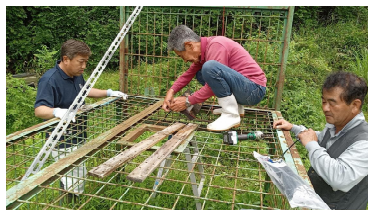
③ 箱裏へ柵自動ロック解除機器の取り付け
