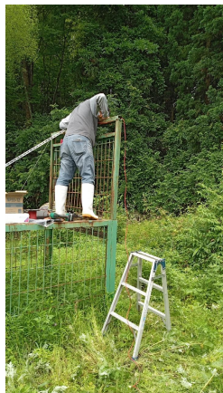
③ 箱裏へ柵自動ロック解除機器の取り付け
