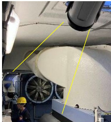
サーモグラフィカメラ取付状態
