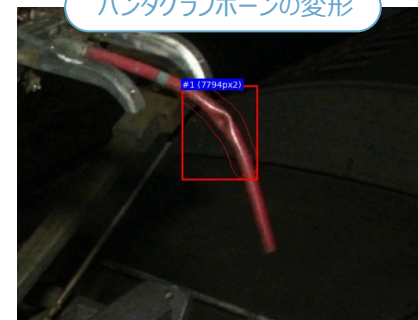
パンタグラフホーンの変形
