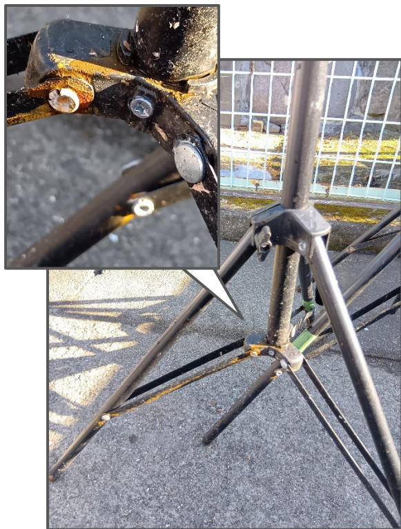
通信器等固定用治具の腐食・劣化状況
