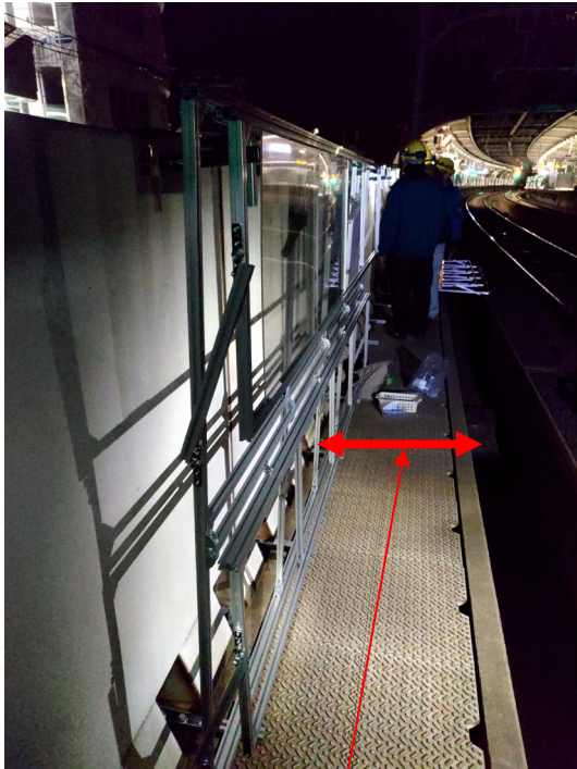
作業員が通行するための幅は、壁にぴったり設置してもぎりぎりであり、実装の際は治具の改良も必要となる
