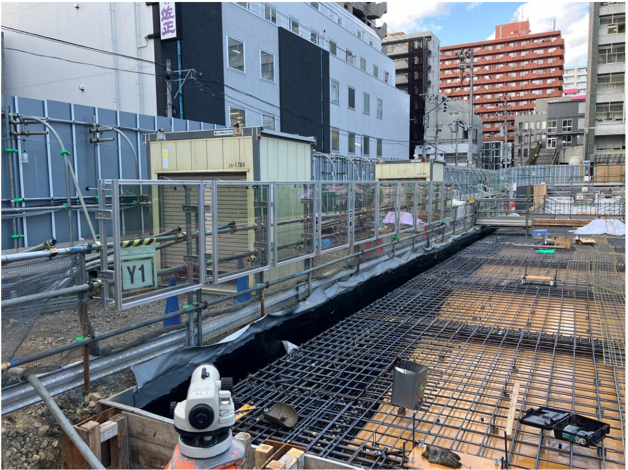
図 3.2-3 4.5GHz 静的反射板設置風景:仙台市新庁舎建替工事現場
