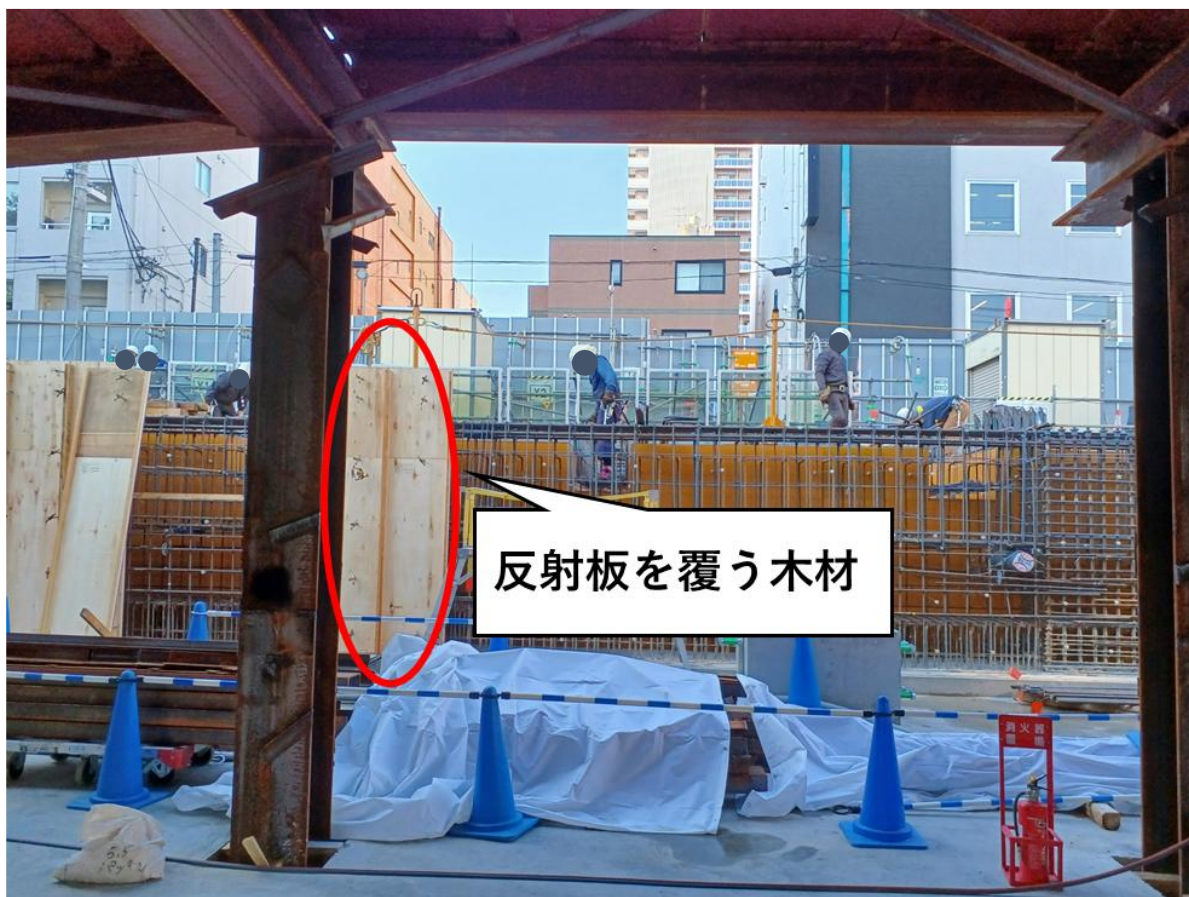
図 6.3-19 木材の設置状況
