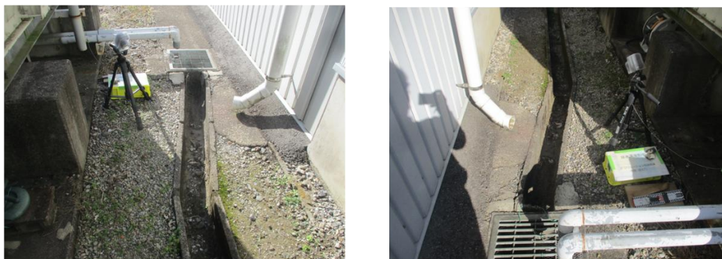
図 5.5-2 排水溝画像採取状況
