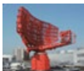
空港監視 レーダー
