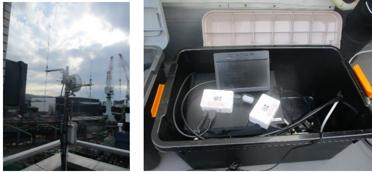
図 4-129 装置の設置状況（上段：船舶、下段：屋上）
