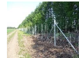
強固な侵入防止柵
