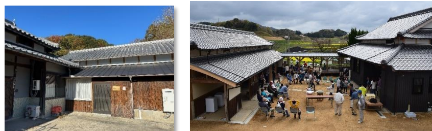
▲ 学生と連携して整備した、古民家を改修した滞在拠点
