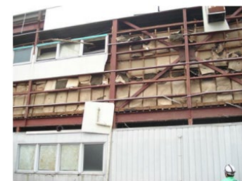
石綿露出状況の調査(目視)
