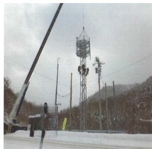
<建設中の基地局>
