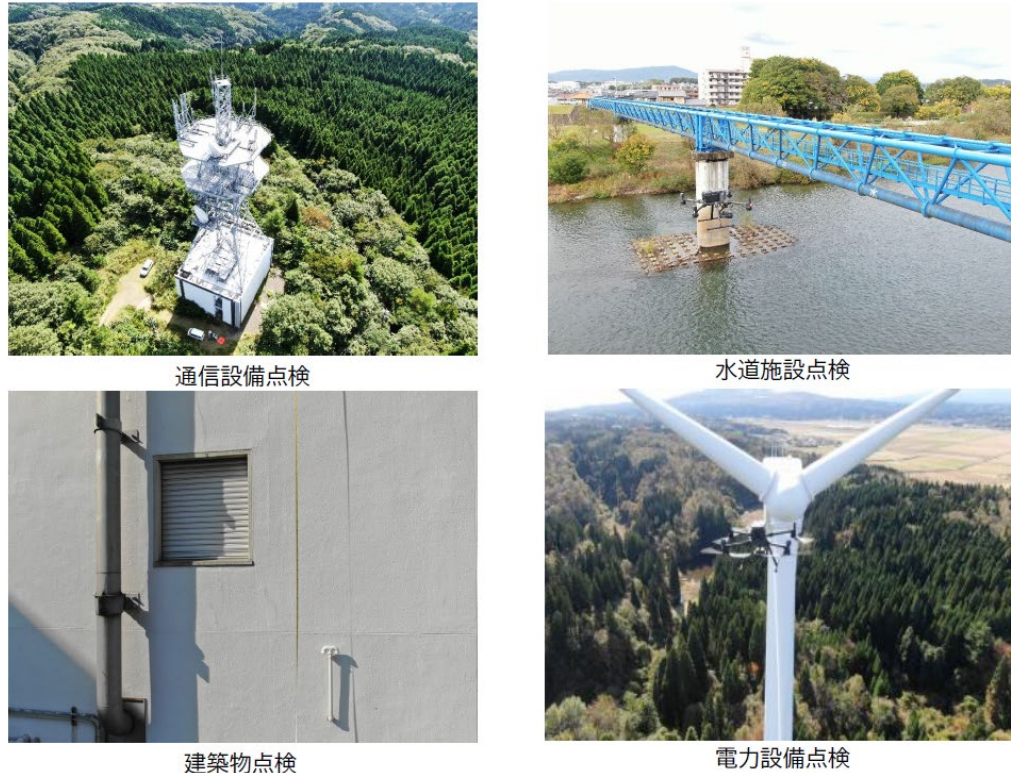
図表 31 ドローンの活用事例 フライトオペレーション事例
