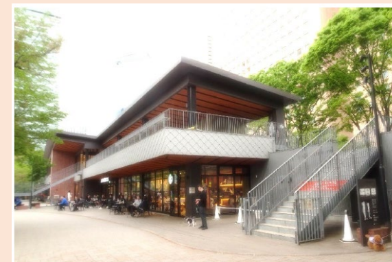
Park-PFIで再整備された新宿中央公園の施設
