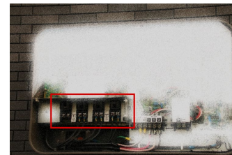
パワーコンディショナ(PCS)のカバーを外した状態 内部の電源スイッチ
