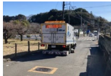
（空洞探査車による調査）
