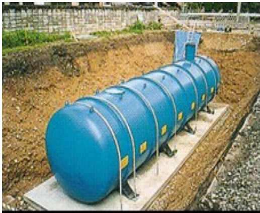
【耐震性貯水槽】
