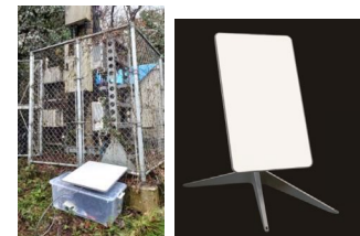
衛星エントランス回線 【伝送路断対策】
