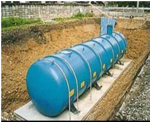
【耐震性貯水槽】
