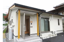
空き家の改修（お試し居住施設）
