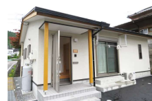
空き家の改修（お試し居住施設）
