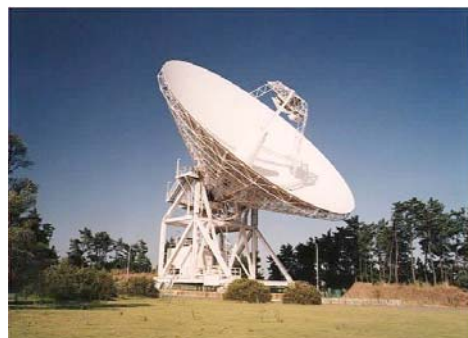
34m アンテナ(いずれも鹿島)
