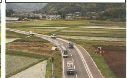
農業用道路の整備
