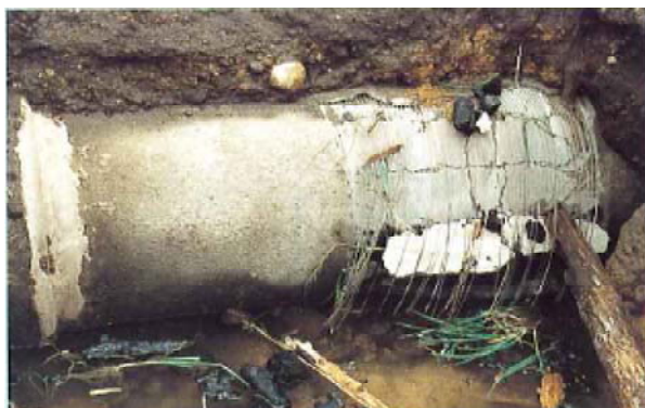
破裂したプレストレストコンクリート(PC)管（群馬用水）
