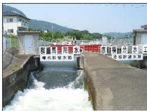
配水状況（群馬用水）
