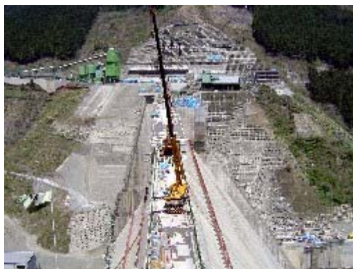
工事中の滝沢ダム（平成17年）
