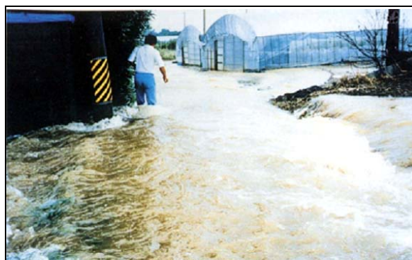
管体破裂による漏水（豊川用水）
