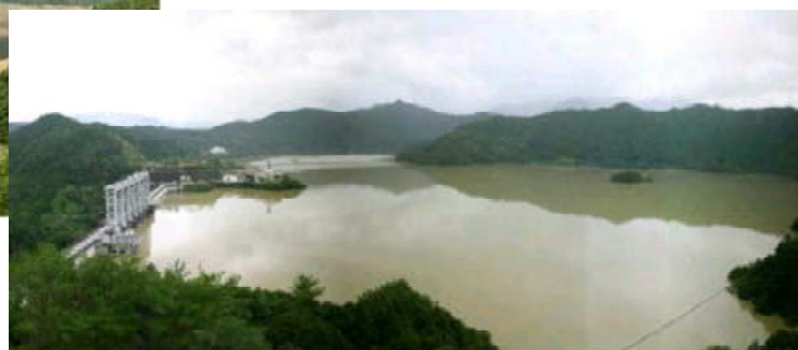
洪水調節後の早明浦ダム
