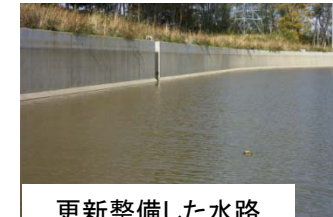
更新整備した水路
