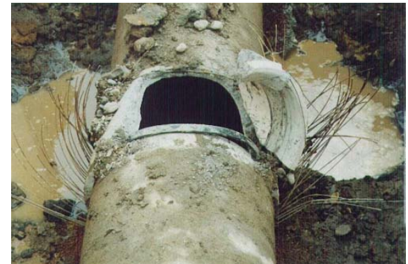
継手部が破損し水が噴出したパイプライン
