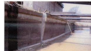
老朽化し、側壁が倒れかかっている幹線水路
