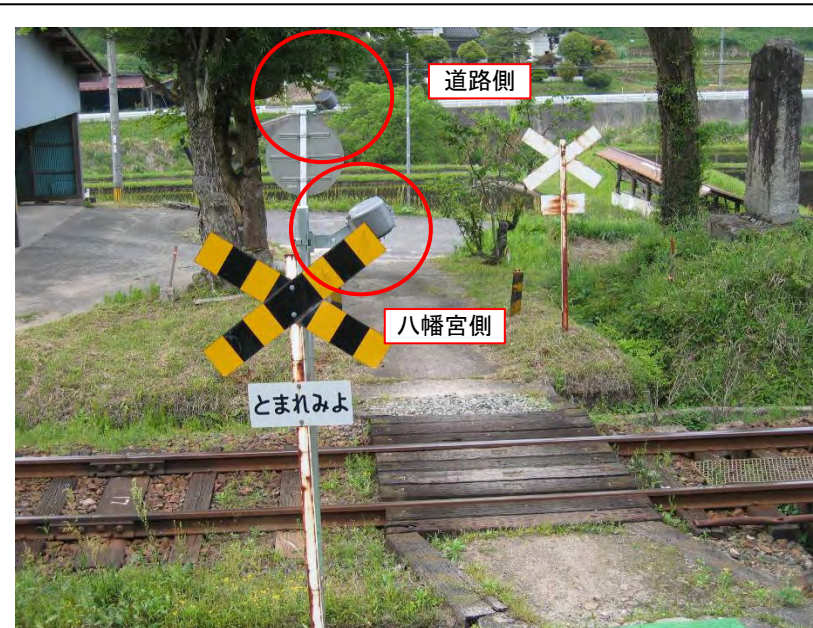
事例14:宮の下踏切(島根県内4種踏切、木次線、下久野駅構内)
