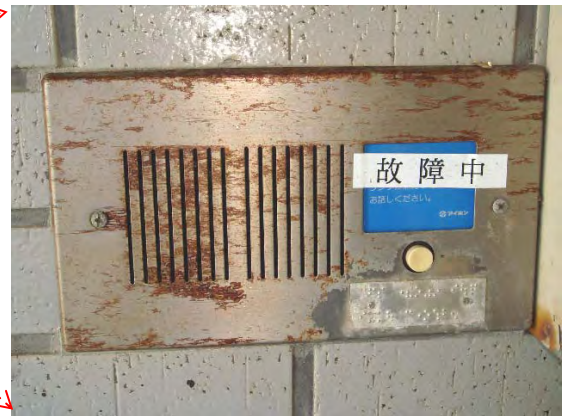
庁舎玄関外側の押しボタン式の呼出装置が故障し使用不能
