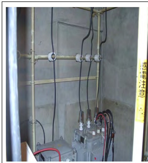
図2 高圧受配電設備（2階）
