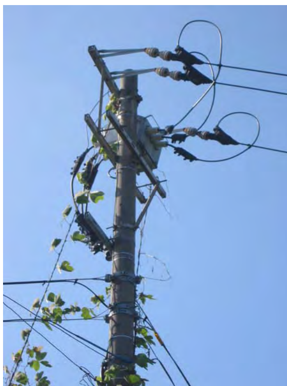
図2 植物が巻きついている構内1号柱
