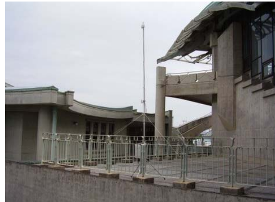
メッシュ型無線LAN屋外機仮設アンテナ
