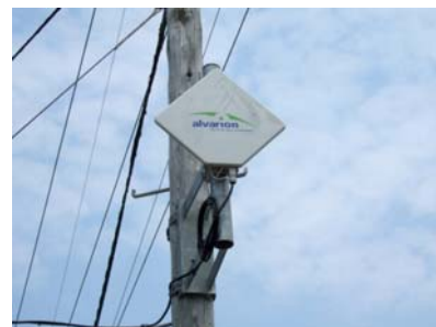
渡嘉志久の加入者局 (前面にホテルがあるため電柱に設置)
