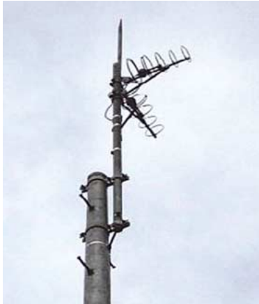
図3-7 送信アンテナ部の例
