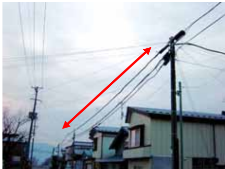
町内全域に敷設された光ケーブル
