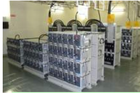
バックアップ蓄電池(交換局)
