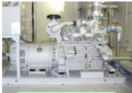
非常用発電装置
