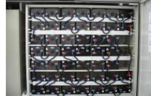
バックアップ蓄電池(基地局)
