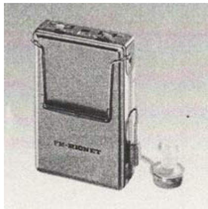
図 3: ポケット形の補聴援助用ラジオマイクの受信機の一例
