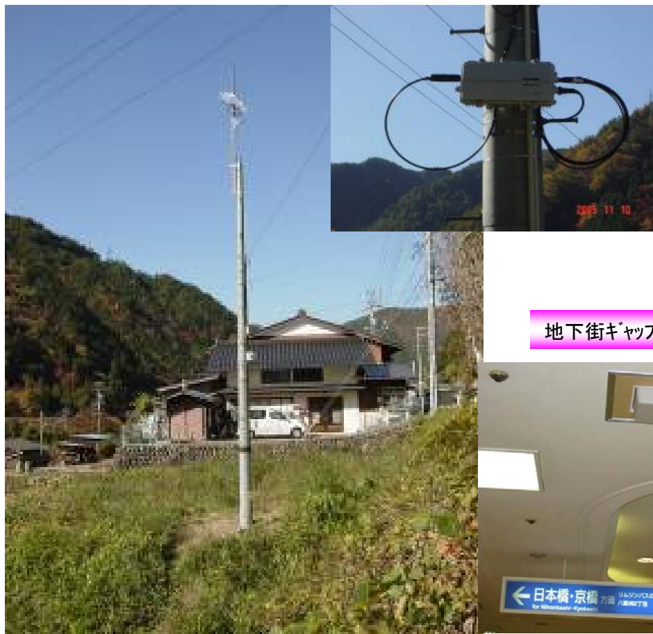
山間部などの条件不利地域向けギャップファイバー(10mW送信)
