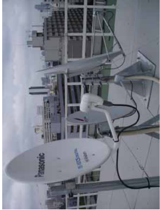
図 36 受信用 45cm 径 パラボラアンテナ
