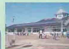
市民出資による太陽光パネル設置
