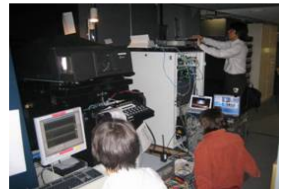
六本木映写機室 プロジェクタ近傍に J2K コーデックを設置
