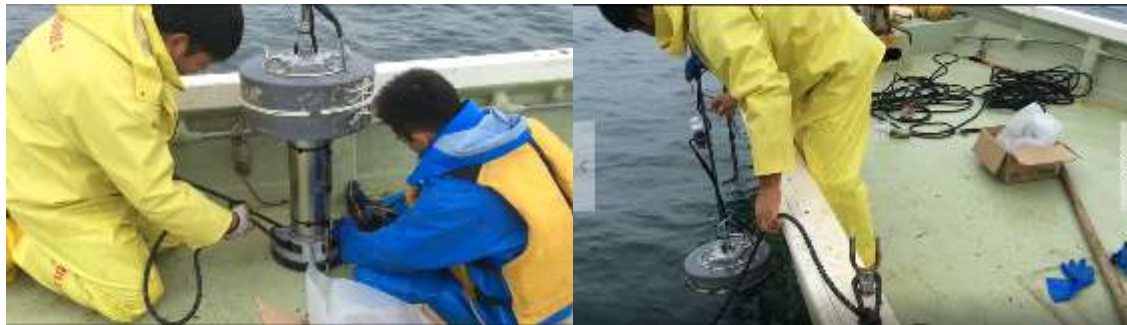
センサバイ 設置作業 (10月)
