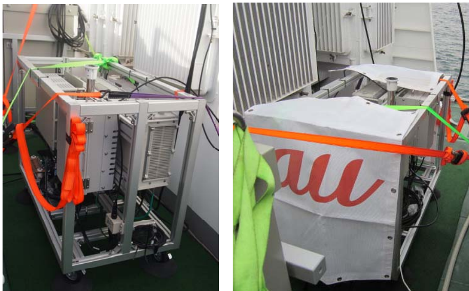
図 8 船舶に設置した携帯電話基地局
