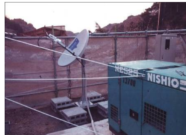
衛星エントランス設置 無線機 調整完了
