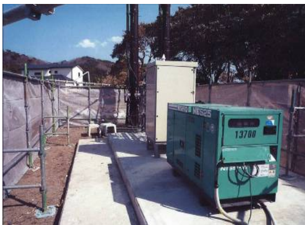
無線機 設置工事
