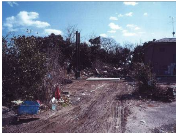
がれき撤去完了
