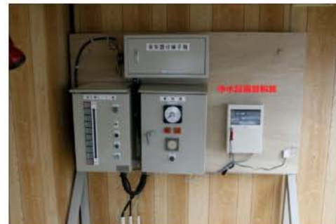
浄水場の水位等を管理している浄水設備警報装置の電子回路
