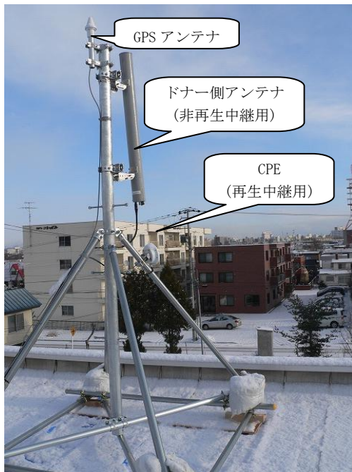
図 4-6 中継局ドナー側アンテナ群(旭川市神居支所屋上、写真左) と CPE(写真右)
