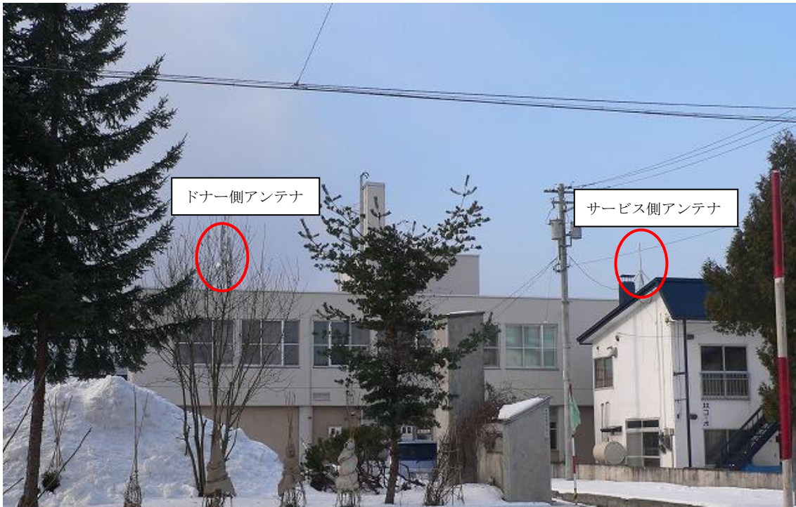
図 4-5 中継局アンテナ全景(旭川市神居支所屋上)
