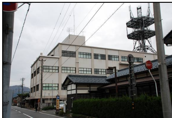
図 資 6-7 NTT大野ビル全景
