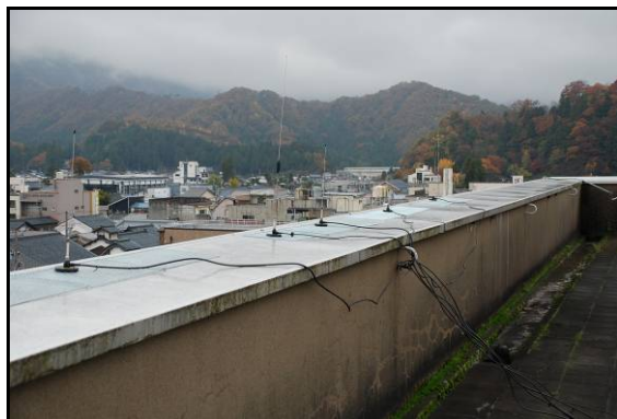
図 資 6-6 NTT大野ビル屋上アンテナ
