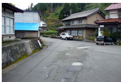
写真 21 調査地点付近状況 1
