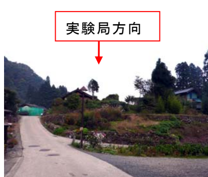
写真 34 越中平実験局方向
