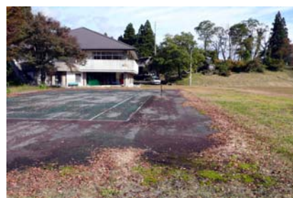
写真 44 調査地点付近状況 2
