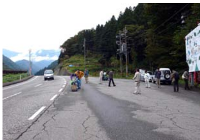
写真 27 調査地点付近状況 1
