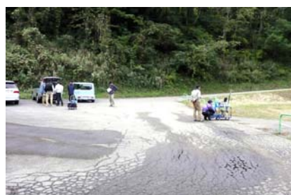
写真 15 調査地点付近状況 1
