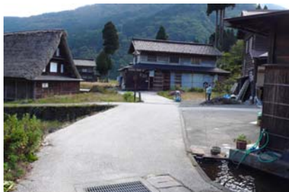
写真 55 調査地点付近状況 1
