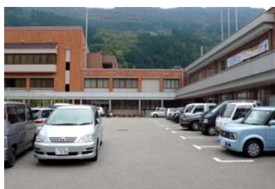
写真4 調査地点付近状況2
