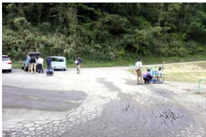
写真 15 調査地点付近状況 1
