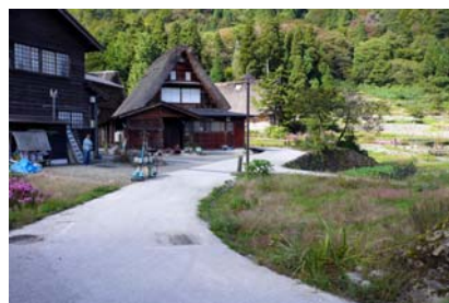
写真 56 調査地点付近状況 2
