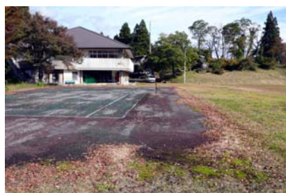
写真 44 調査地点付近状況 2
