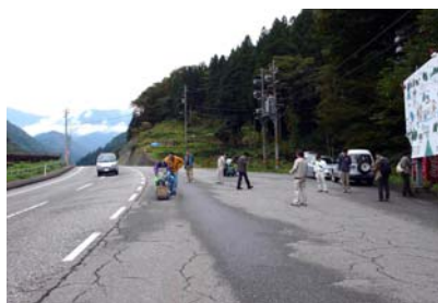
写真 27 調査地点付近状況 1
