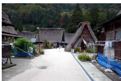
写真 48 調査地点付近状況 1
