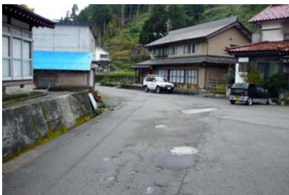
写真 21 調査地点付近状況 1
