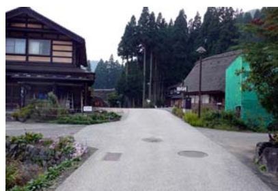
写真 38 調査地点付近状況 2
